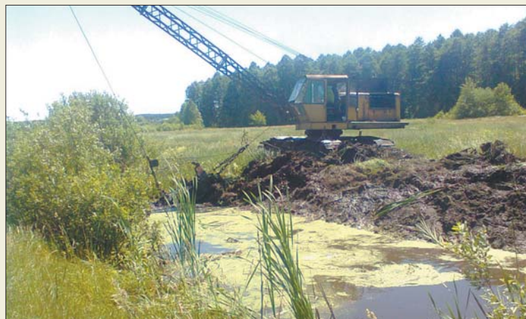
На очищенні каналу працює техніка Маневичького УВГ
