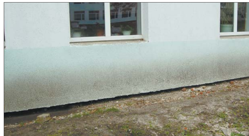
Після дощів на стінах залишаються сліди
