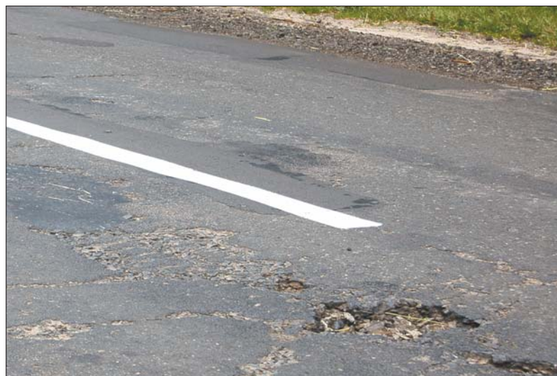
Цю ділянку дороги за Заборолем ремонтували навесні
