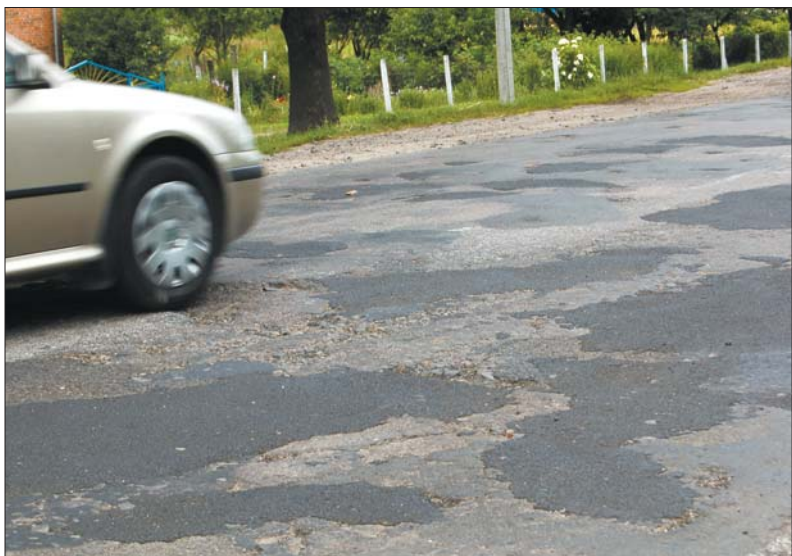
Тут не ями латати — капітальний ремонт потрібен.
