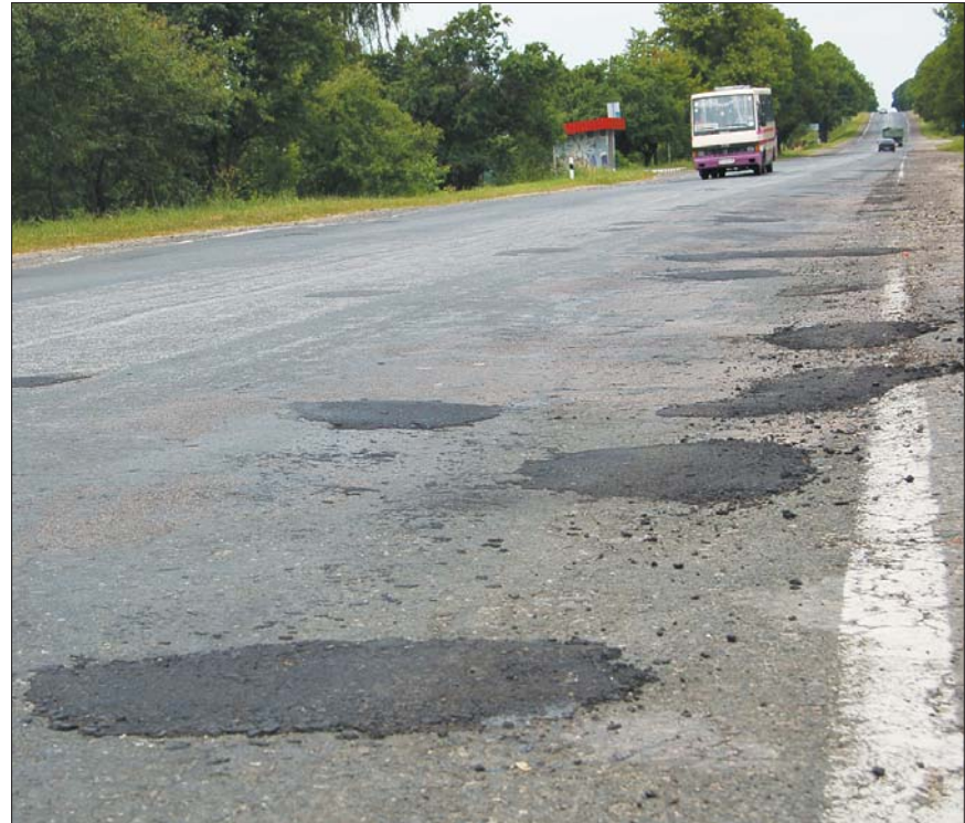
Після ямкового ремонту стрибаєш, як по драбині
