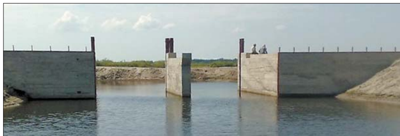
На добудову нової споруди Вижівського водозабору необхідно 2,6 мільйона
