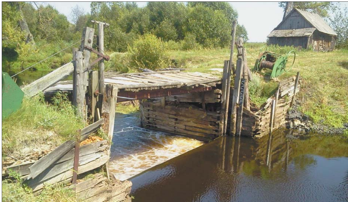
Споруда Вижівського водозабору, збудована 1856-го року, вже майже розвалена
