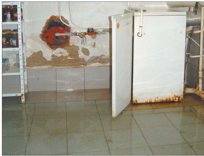
Затоплені у підвалах котли виходять із ладу та становлять небезпеку для життя людей
