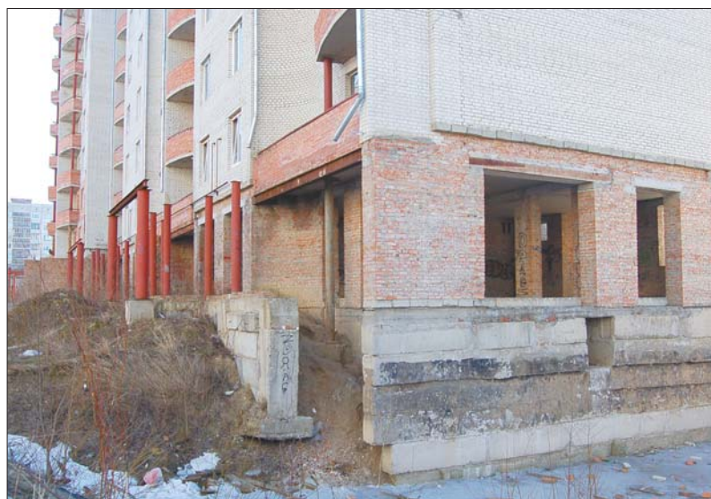
У будинку другої черги почав руйнуватися фундамент
