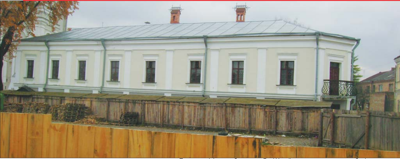
Перед самісіньким будинком Лесі Українки скоро розпочнуть будівництво
