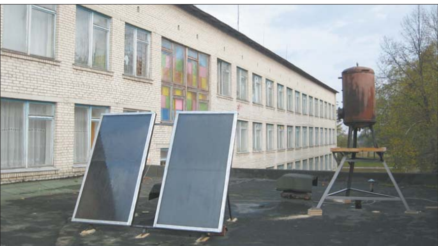
На даху Колківської школи триває монтаж сонячного водонагрівача
