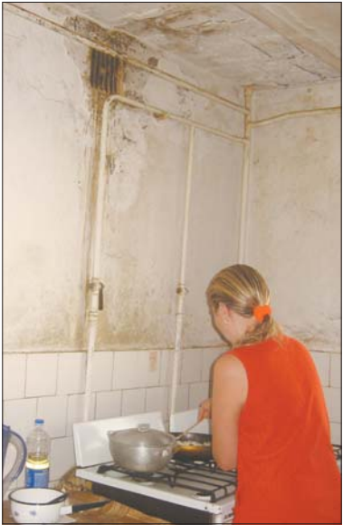
Іржава панель, яка може дати тріщини
