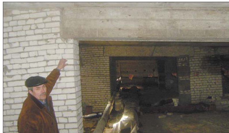
На одній цеглині тримається балка перекриття
