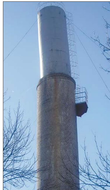
Водонапірна башта в аварійному стані
