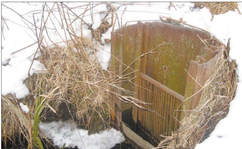
Перекритий шлюз, який не пускає воду до водойми Олега Поліщука
