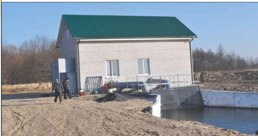
Насосна станція у Любешові
