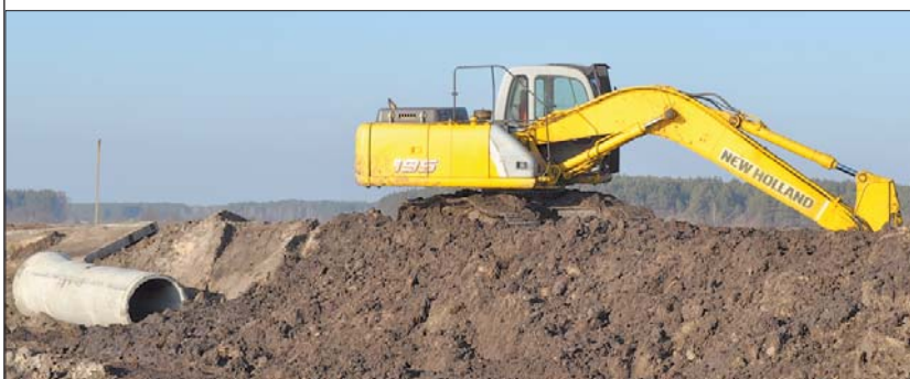
Будівництво дамби у селі Люб'язь
