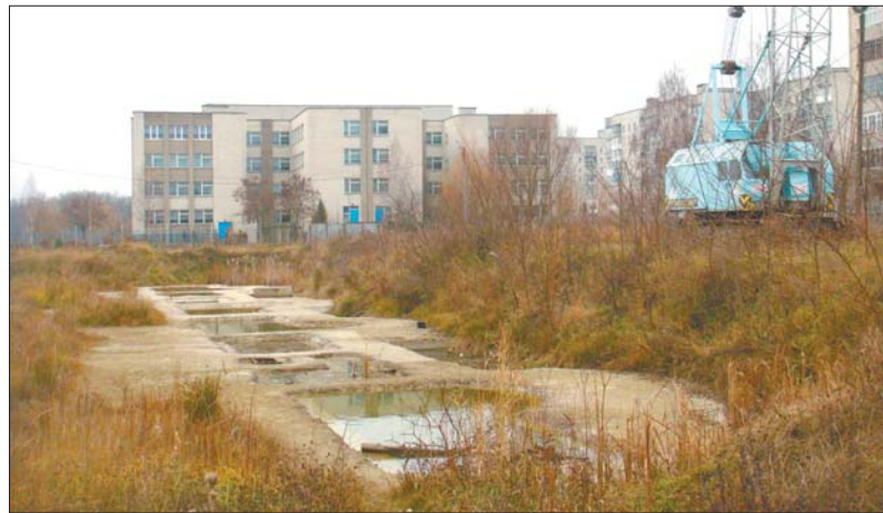
Затоплений фундамент обіцяного будинку на вулиці 40 років Перемоги, 10
