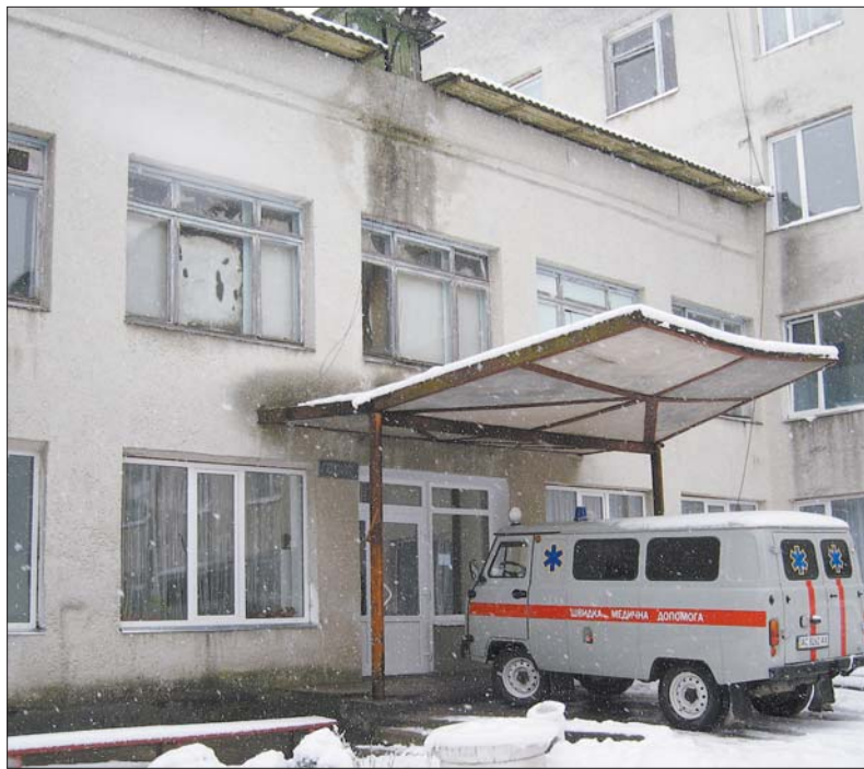
Приймальне відділення лікарні: дах тече, вікна замінені частково
